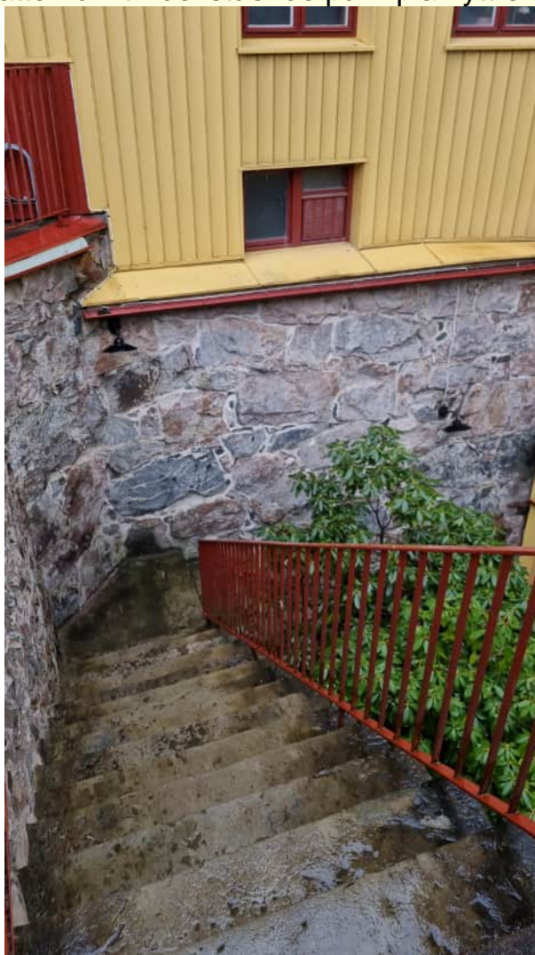
2.2 Vatten blir till del stående på vilplan yttre trappa
