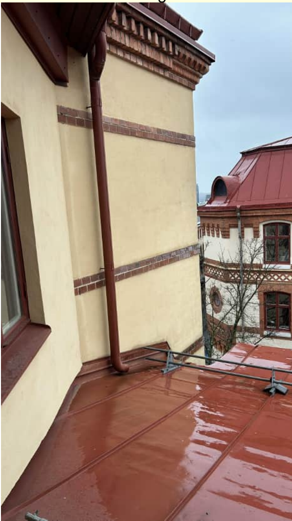
1.1 Takfot och takavvattning
