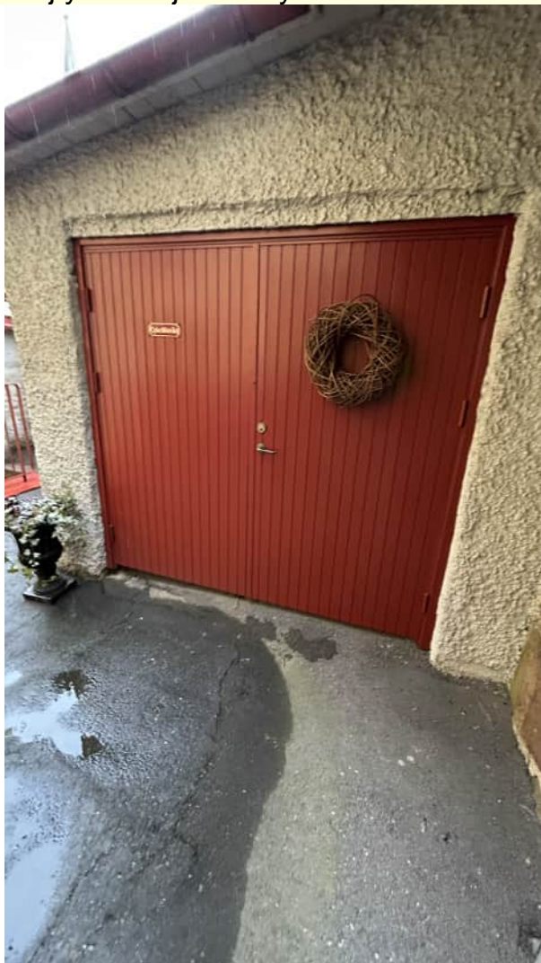
2.2 Vatten blir till del stående på vilplan yttre trappa
