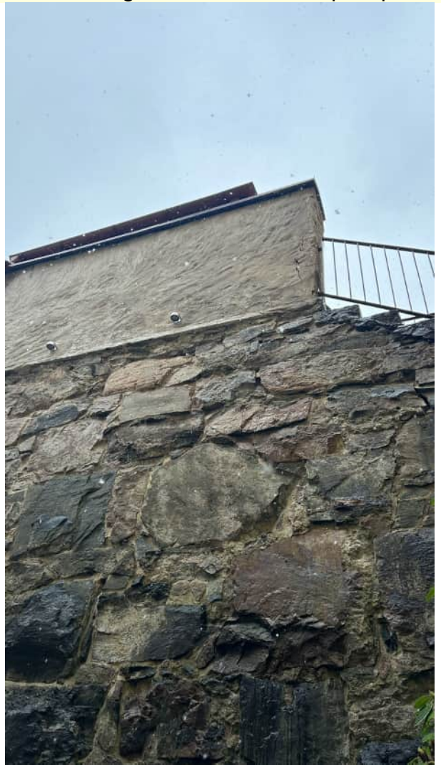
2.1 Bild från innergården, krackelerad puts på miljöhus
